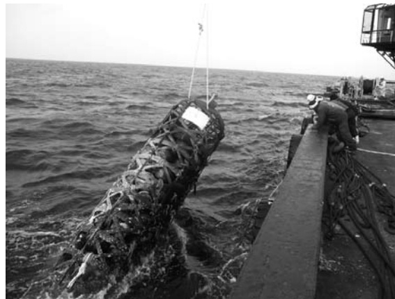
写真3 「簡易型」のFADs:伊良部漁協自作のパヤオ本体の投入作業 (提供:沖縄県伊良部漁業協同組合)
